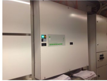
Turvavalokeskus sähköpääkeskuksessa
