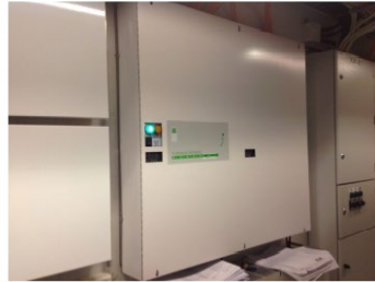
Turvavalokeskus sähköpääkeskuksessa
